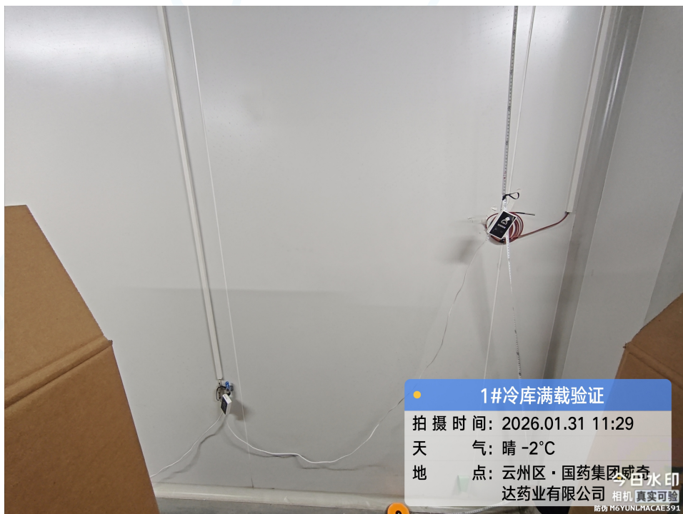
满载验证现场3
