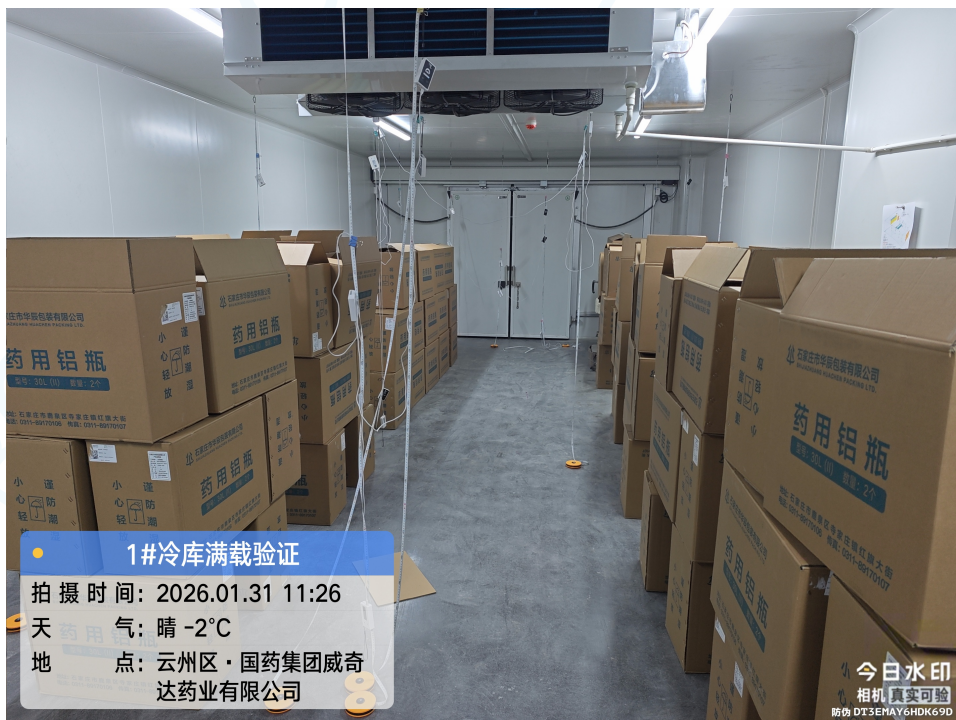
满载验证现场1
