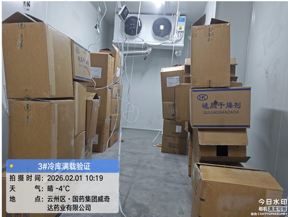
满载验证现场2
