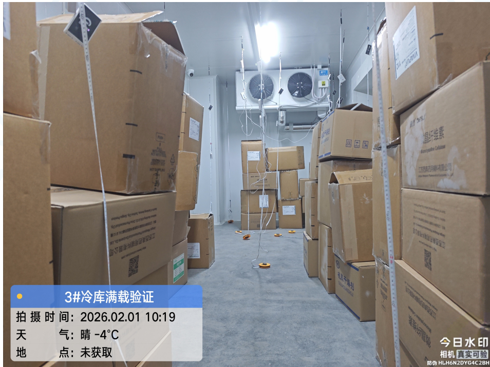
满载验证现场1
