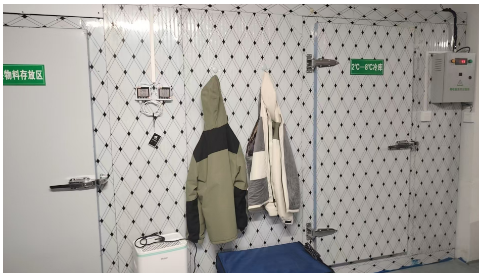
冷库外观及仓库外温布点
